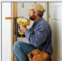
Крепление дверных рам к различным видам оснований
