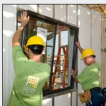
Крепление оконных рам к различным видам оснований
